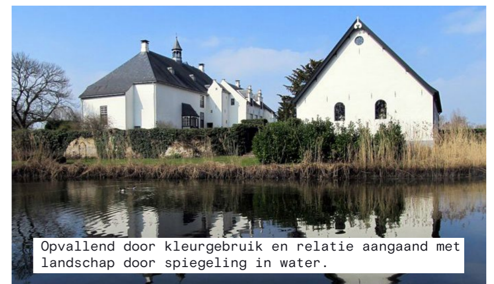
Kopgevel aan einde van t-splitsing. Woning met grote ramen en accent in dakgoot raampje.
