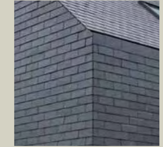
Grijze lei gevel en dak.
