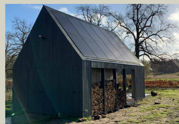
Prachtig mee-ontworpen pv-panelen in zorgvuldig vorm gegeven schuur.
