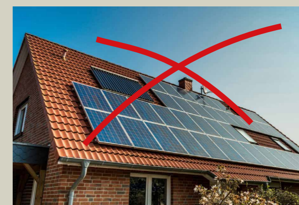
Niet zo: achteraf rommelig opgeplakte PV-panelen
